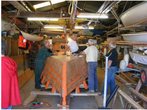
1. le fond est terminé
